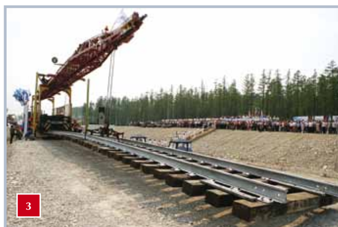
СТРОИТЕЛЬСТВО ЖЕЛЕЗНОЙ ДОРОГИ
