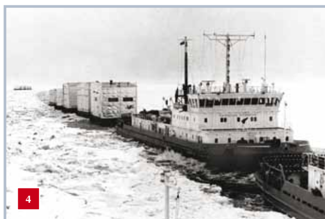
ПРОВОДКА СУПЕРБЛОКОВ ДЛЯ ЯМГУРГСКОГО МЕСТОРОЖДЕНИЯ ВО ЛЬДАХ ОБСКОЙ ГУБЫ
