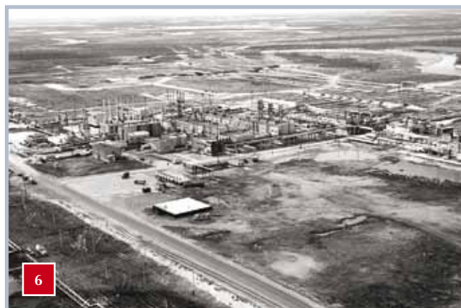
УСТАНОВКА КОМПЛЕКСНОЙ ПОДГОТОВКИ ГАЗА НА ЯМБУРГСКОМ МЕСТОРОЖДЕНИИ
