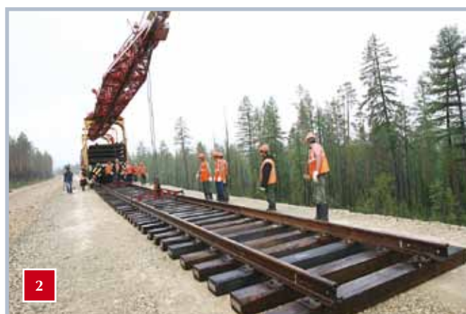
СТРОИТЕЛЬСТВО ЖЕЛЕЗНОЙ ДОРОГИ
